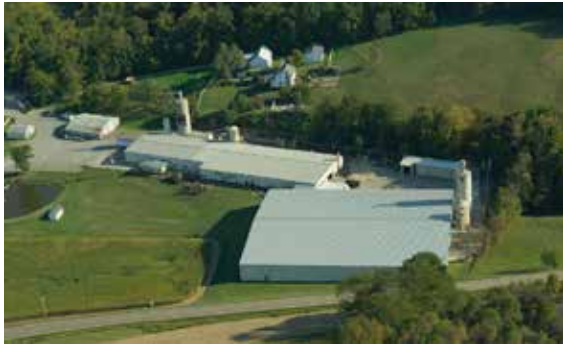
La ubicación de Walnut Creek Planing en Holmes County, Ohio USA.
